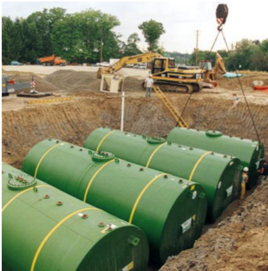
Slika 18. Postavljanje podzemnih čeličnih rezervoara
