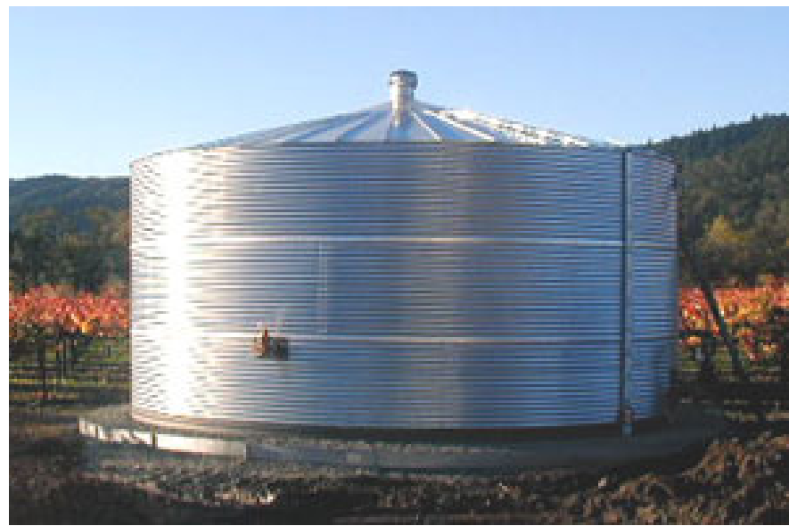
Slika 14. Rezervoar od galvanizovanog rebrastog čelika kapaciteta do
