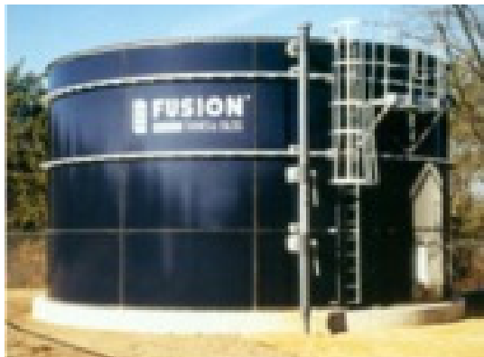
Slika 16. Rezervoar za vodu od stakla i čelika kapaciteta 75 000 litara
