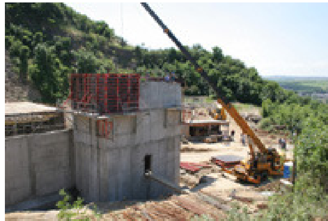
Slika 22. Izgradnja rezervoara od armiranog betona (u Rakovici) dimenzija 24,55x36,75x6,5 m
