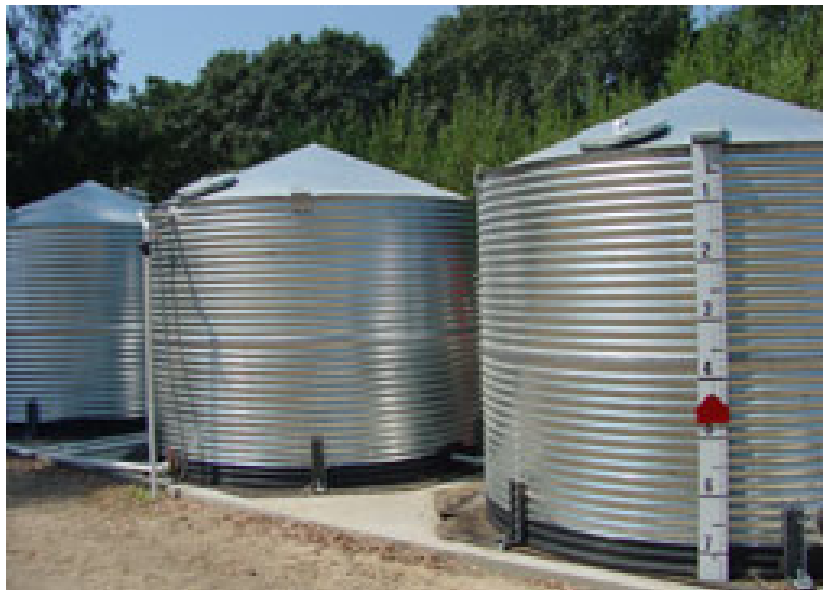
Slika 14. Rezervoar od galvanizovanog rebrastog čelika kapaciteta do
