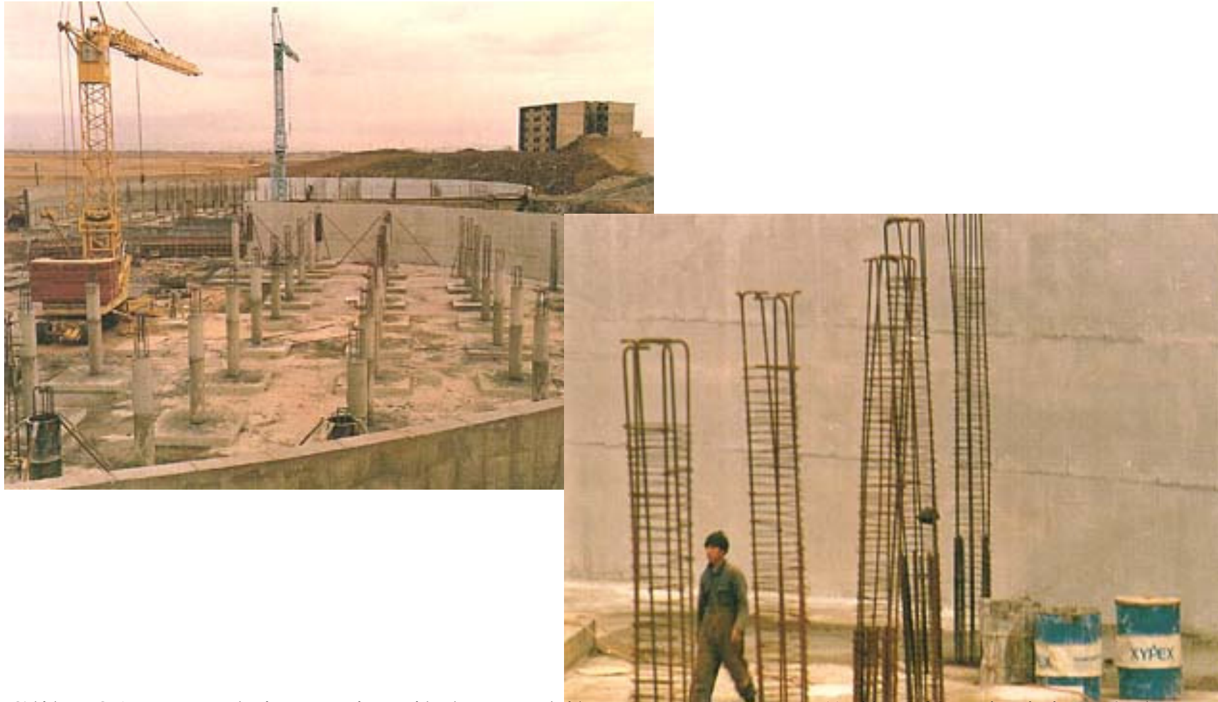
Slika 21. Izgradnja armiranih betonskih rezervoara, prečnika 60m i visine 4.5m
