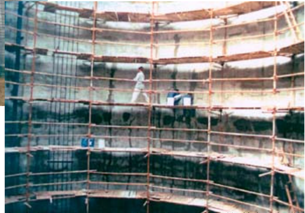
Slika 20. Cilindrični betonski rezervoari visine 16m – spoljašnji i unutrašnji izgled
