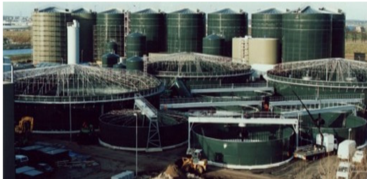
Slika 17. Kompleks rezervoara od čelika i stakla
