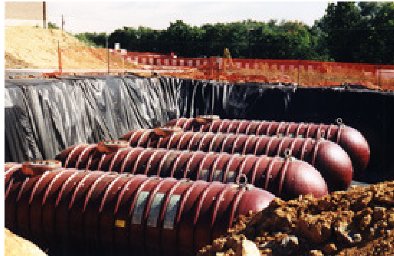
Slika 23. Ugradnja podzemnih rezervoara za vodu od fiberglasa
